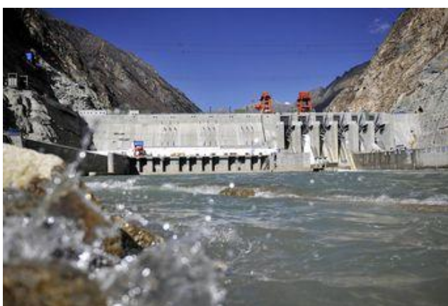
Staudamm von Zangmu am Yarlung Tsangpo
